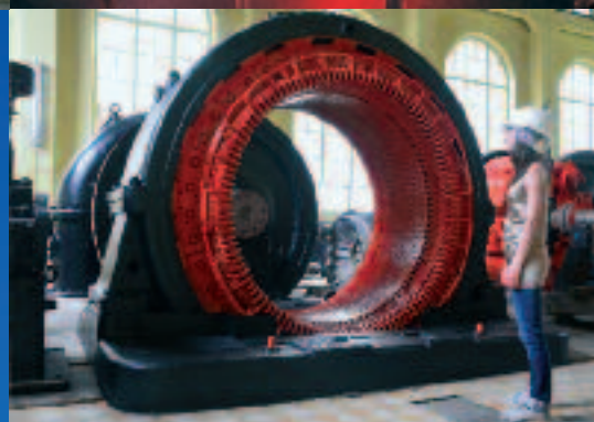
La centrale hydraulique d'Avrieux.
