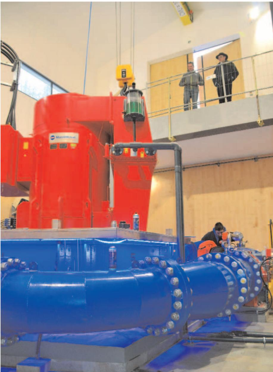
Ci-contre, la nouvelle centrale du Charmaix à Fourneaux. Equipée d'une turbine Pelton à 5 injecteurs, elle fournit l'équivalent de la consommation de 600 foyers.
