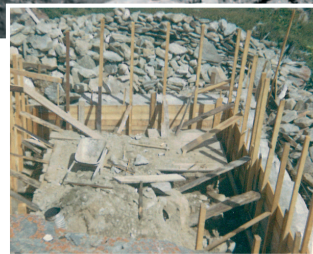
Les fondations du premier refuge, qui sera ensuite utilisé par les gardes du PNV. Sur ce chantier d'altitude, tout était fait à l'économie : les vieilles poutres servaient aux échafaudages, les clous étaient récupérés... 4 mois de labeur qui permettent aussi de se rendre compte du travail effectué par les générations précédentes.
