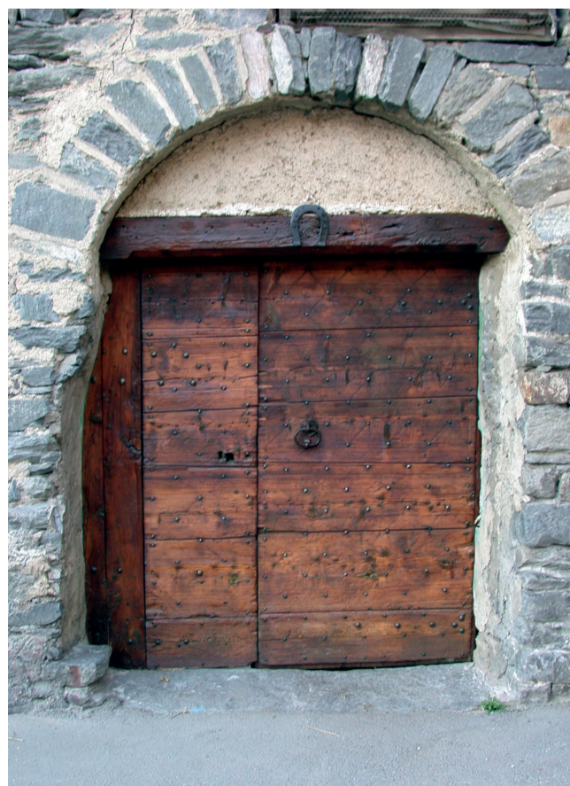
Le « poër » est une entrée voûtée qui distribue à la fois l'écurie, la grange, la cuisine et l'accès aux chambres de l'étage. On trouve notamment ce type d'architecture dans le village d'Aussois.
