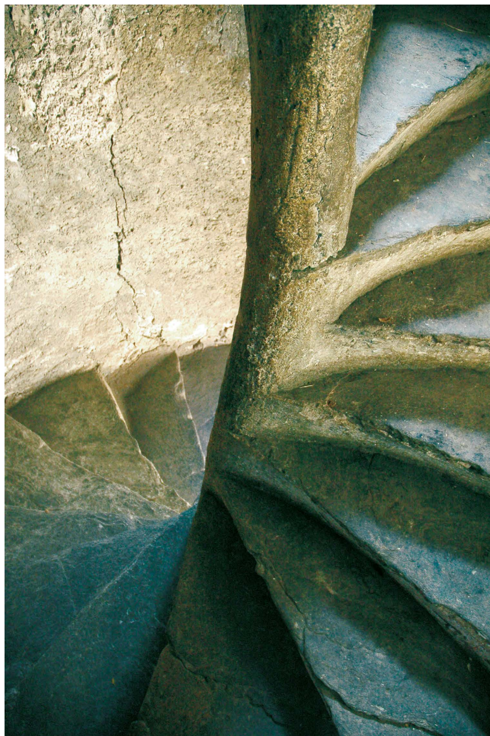
L'escalier le plus ancien ? Cette maison de Saint-André porte la date de l'an de grâce 1585.
