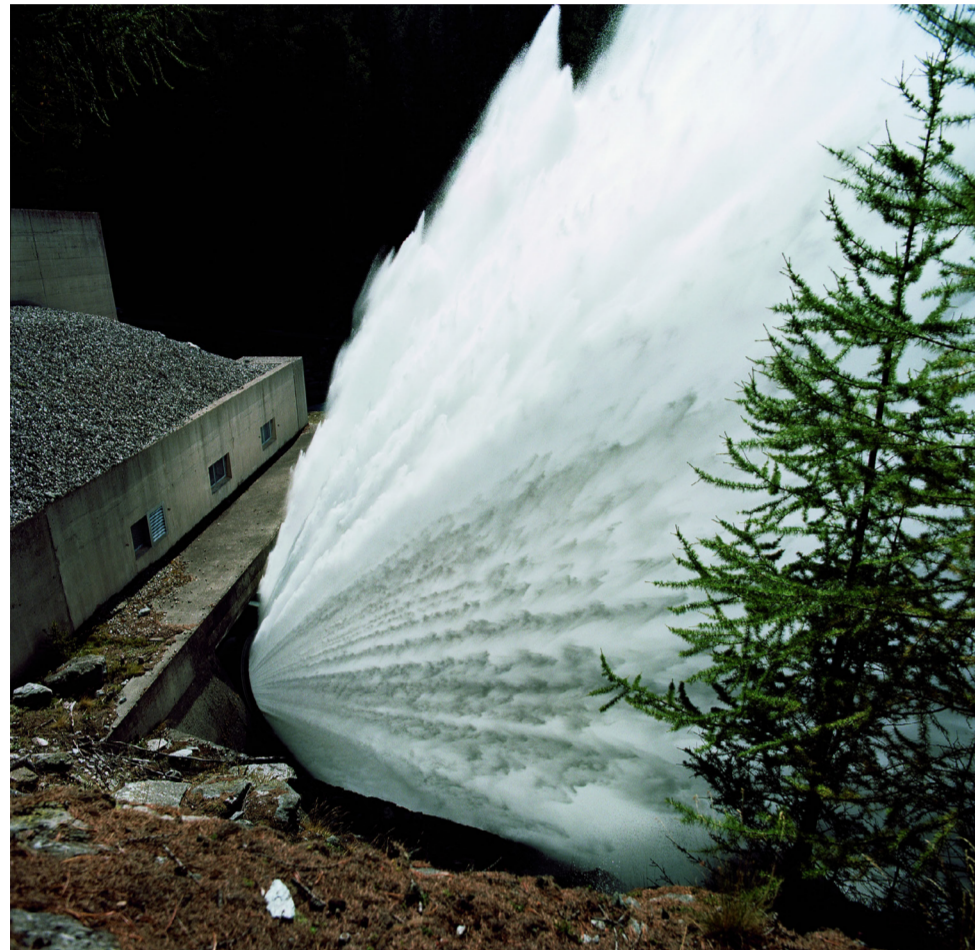
Val-Cenis Bramans, essai annuel des vannes « jet creux » de vidange du barrage du Mont-Cenis. Ph. S. BONNOT
