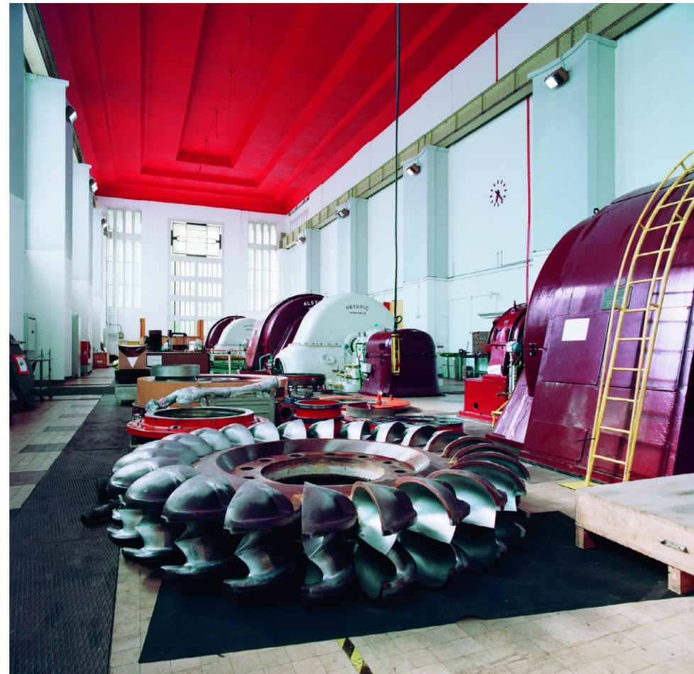
Le Freney, roue pelton d'un groupe de production en cours d'entretien, centrale de Bissorte Ph. S. BONNOT
