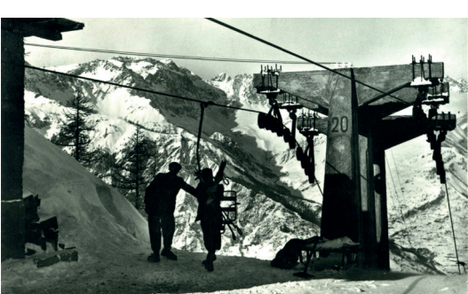
Le premier télésiège au Colomion, avec pylône en béton. La prima seggiovia Colomion, con pilone in cemento.
