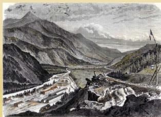
Construction des premiers bâtiments de la place de la gare. Un drapeau et une lanterne signalent la voie de décharge des déblais en provenance du tunnel et à destination de la future place. (gravure l'illustration A Derdy, coll A Peynichou)
