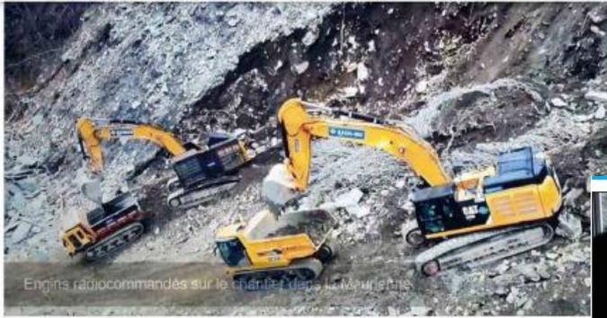
Engins radiocommandés sur le chantier dans la Maurienne
