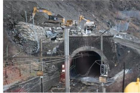
Le chantier au-dessus de la galerie. Les pelleteuses et les camions évacuant les engins ne sont pas occupés, mais télécommandés. En bas, la voie ferrée et les caténaires endommagés. Photo Le DL, JF.
