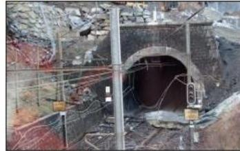
L'entrée Est du tunnel a été impactée : des blocs ont atterri sur la voie ferrée et les protections par barrière de traverses et rails ont été complètement détruites.
