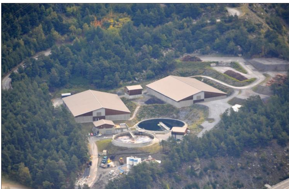
La station d'épuration de La Praz, sur la commune de Saint-André, est gérée par la CCHMV.
