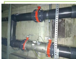
Un des canons UV mis en place à la piscine pour un nouveau traitement des chloramines de l'eau des bains par ce procédé
