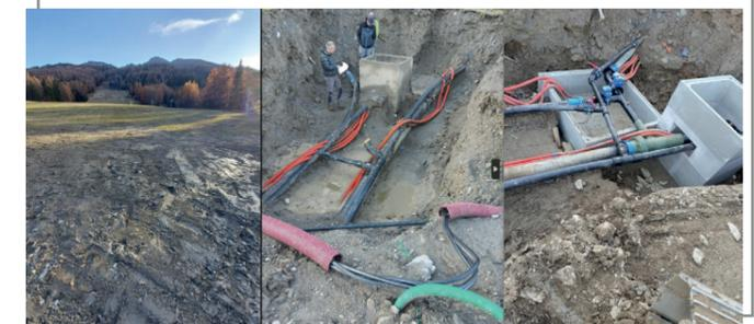
Mise en place de vannes de sectionnement sur les réseaux neige sous la piste des Granges.
