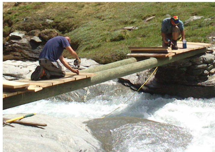
Vérifier, réparer les ouvrages de franchissement (ponts, passerelles), c'est aussi le travail d'entretien du printemps. Photo Archives Terra Modana
