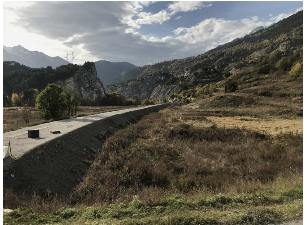
La zone des Moulins. La partie à droite du chemin sera occupée par les installations de surface du chantier.
