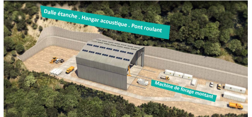
La plateforme du chantier avec le hangar qui abritera la machine de forage montante.
