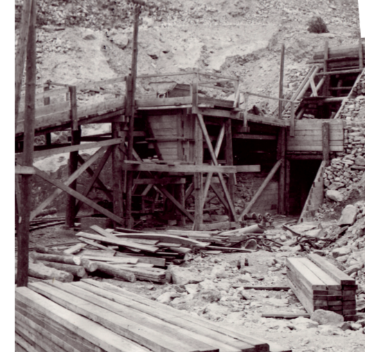
Travaux de reconstruction du tunnel ferroviaire du Mont-Cenis 1945 - 1946 (photos Rail Savoie)
