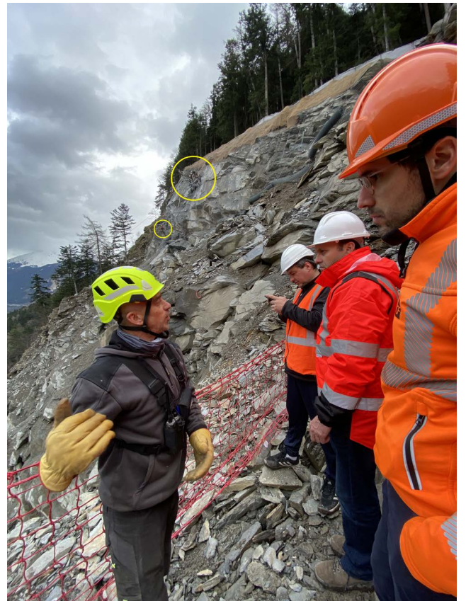
Sur le haut de la falaise, 250 m à l'aplomb de la voie ferrée, Ludovic Vincentini, chef d'équipe de l'entreprise Citem explique comment il mène les travaux de purge puis de consolidation de la falaise. Les équipes (cercle jaune) se relaient toute la semaine, 7j/7 dans des conditions difficiles, même par -10°. Ph. Bruno CILIO
