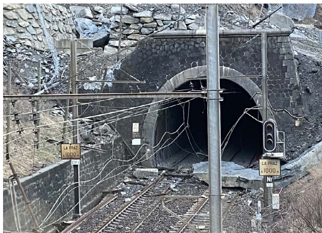
A gauche, le ballet des pelles mécaniques radiocommandées pour le déchargement de la galerie. A droite, la photo montre les dégâts : Voie 1 et 2 endommagées en tête de la galerie côté Modane sur une trentaine de mètres ; une caténaire arrachée voie 1 en tête de la galerie ; fronton de la galerie touché (à gauche) ; filets détecteurs arrachés ou endommagés. A vérifier : la fibre optique, la signalisation ferroviaire... Photos René CHEMIN et Bruno CILIO
