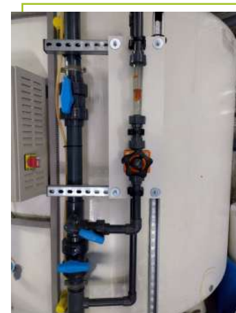
Système permettant le renouvellement de l'eau des bains de la piscine
