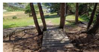
Espace slopestyle et Bike Park Fourneaux avant travaux
