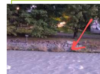
Crue de l'Arc : trop plein des postes de relevages qui étaient sous le niveau de l'eau
