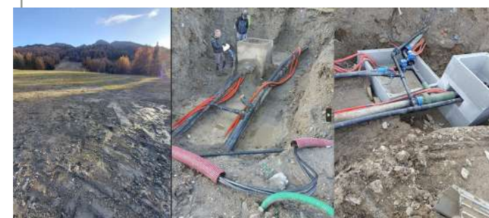
Mise en place de vannes de sectionnement sur les réseaux neige sous la piste des Granges.
