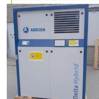
Arrivée et montage du nouveau compresseur à la station d'épuration qui permet un gain énergétique
