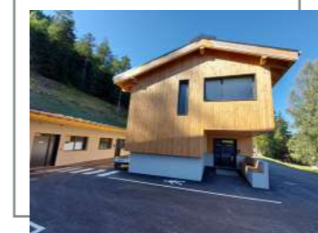
Aménagements extérieurs du nouveau centre technique construit en 2022 en remplacement des précédents locaux techniques situés sous la gare de la télécabine du Mélezet.
