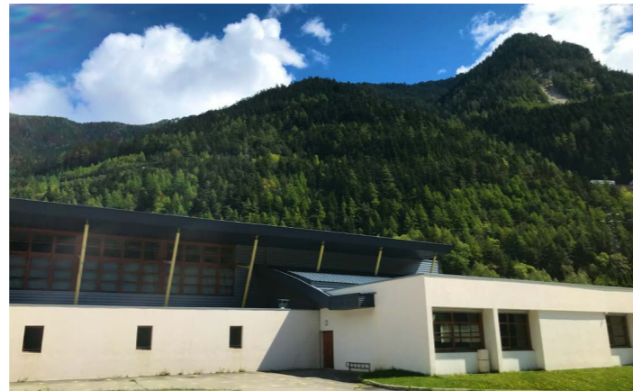
Vue extérieure du gymnase des Terres Blanches dont la rénovation des sols s'opère avec un traitement par quart afin de garder le gymnase ouvert.
