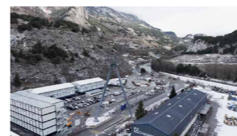
Plateforme VBM (Villarodin-Bourget - Modane) - Chantier Opérationnel 5 (CO5) groupement ELYOT
