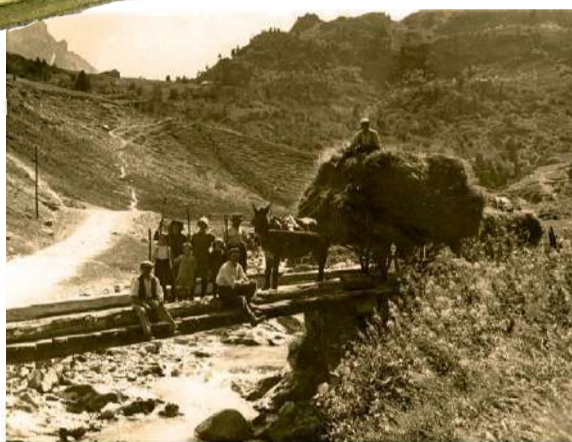
Modane pont du Lavoir transport de foin. Coll. P. NUER.
