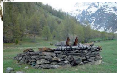
Bessans, vallée d'Avérole arrivée du câble installé en 1934 (photo BJA).
