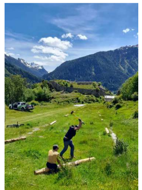
Le démarrage des travaux en mai 2025.
