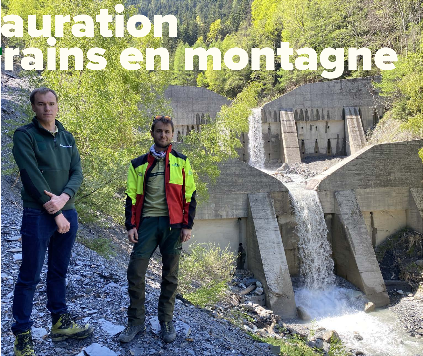
Nicolas Graczyk, responsable de secteur RTM Haute-Maurienne et Guillaume Leleu, responsable du Pôle Territorial Savoie Sud, devant le plus gros ouvrage de correction torrentielle du lit du Charmaix, à Fourneaux. Ph. Bruno CILIO
